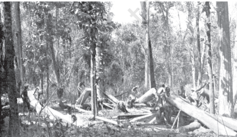
चित्र 3 - सिंहभूम के जंगलों में साल के तनों से ‘स्लीपरों’ का निर्माण, छोटा नागपुर, मई 1897.
