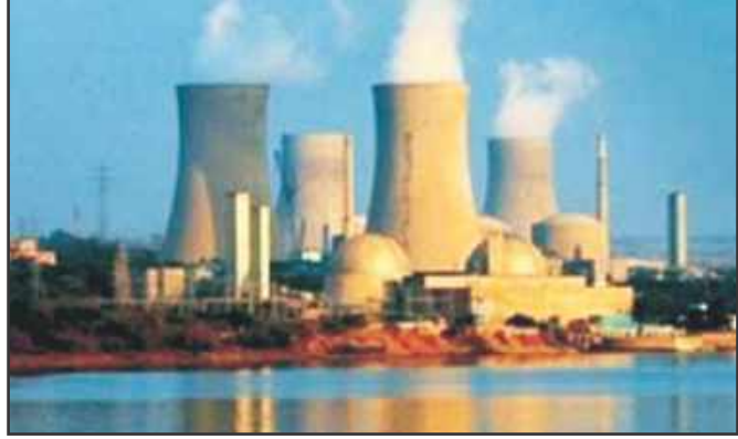
रावतभाटा परमाणु बिजली घर
