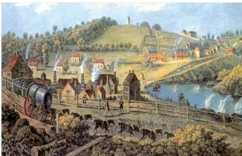
चित्र 9.3 : कोलब्रुकडेल औद्योगिक क्षेत्र का चित्र: लोहे की धमनभट्टियाँ और काठकोयले की भट्टियाँ। घोड़ों द्वारा खींची गई रेलपट्टी पर चलने वाली गाड़ी। (एफ. वाइवेर्स द्वारा की गई चित्रकारी सन् 1758)
